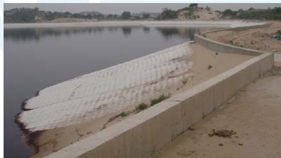
图8 模袋混凝土护坡
