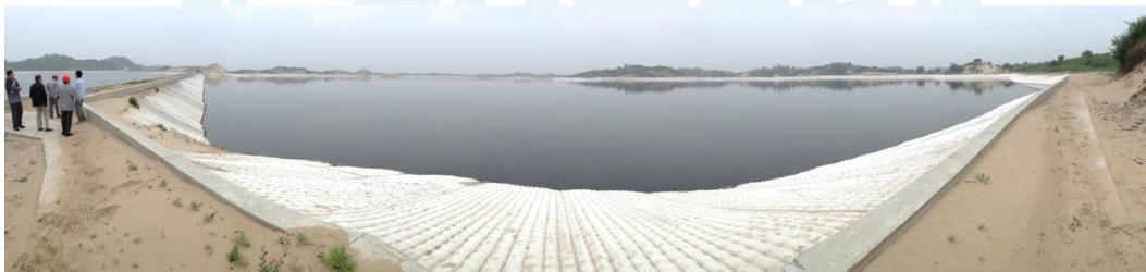
图1 竣工贮废液后的蒸发塘
